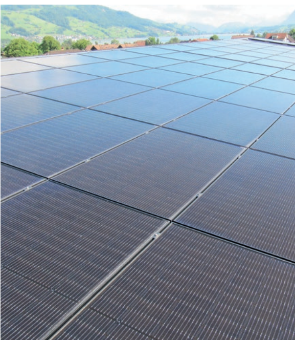
Montierte PVA auf Dach Werkhalle Alligo AG
