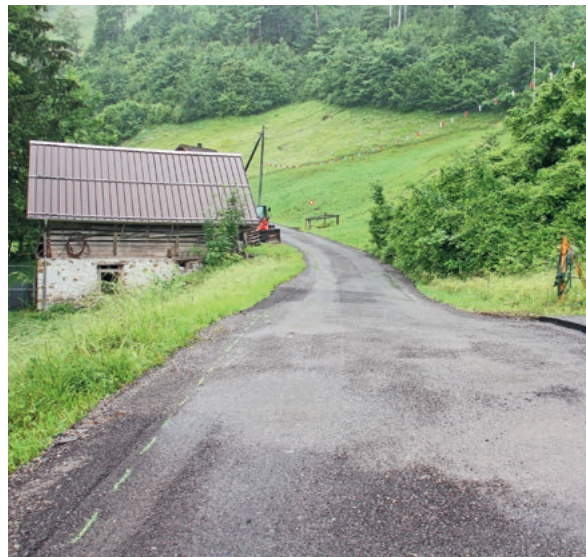
Fertige Feinplanie kurz vor dem Belagseinbau, Abzweigung Laui
