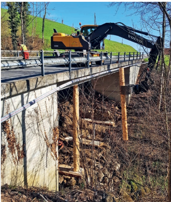
Montagearbeiten Unterspriessung Schwandachgrabenbrücke
