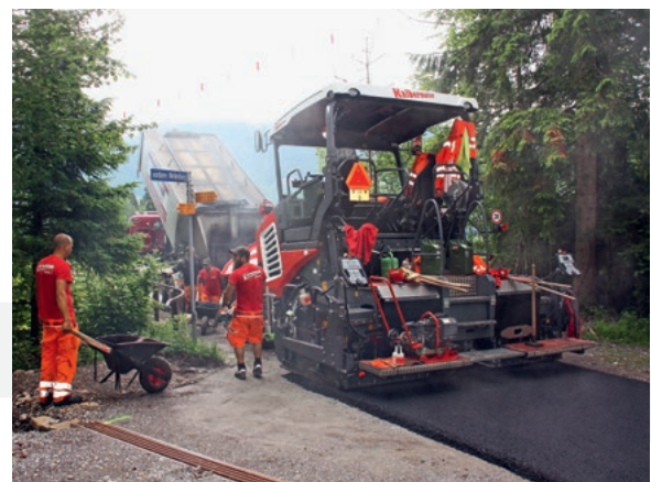
Belagseinbau bei der Rotmoosgrabenbrücke
