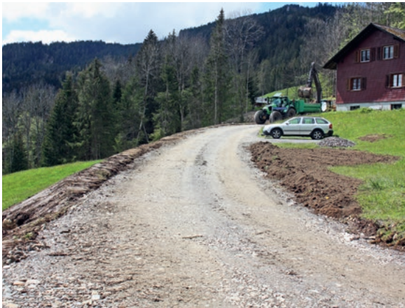
Fertig erstellte Rohplanie im Bereich Schwand
