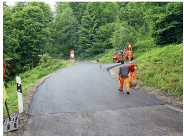
Fertig eingebauter HMT im Bereich Schwalbennest
