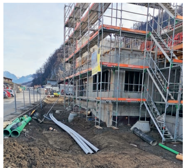
Kabelleitungen vor dem definitiven Einbau
