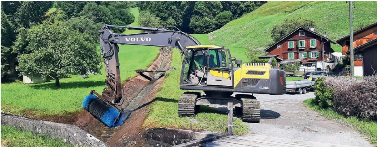
Reinigen der Bachschale im Eichbuelgraben mit Kkehrbürste
