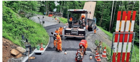
Einbau des HMT Belags im Bereich Schwalbennest
