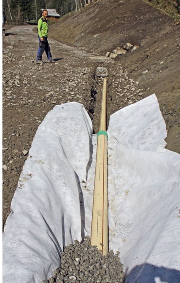
Einbau der Sickerleitung hinter Schwand
