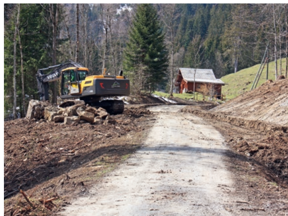
Gestalten der tal- und bergseitigen Böschungen vor Grosschwand
