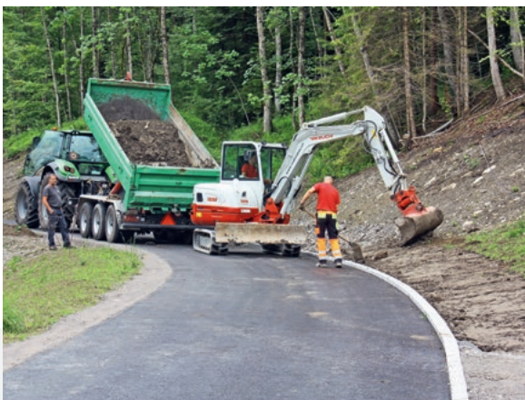
Angleichen der Böschungen und Bankette nach dem Belageinbau
