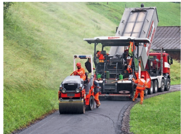
Belagseinbau durch Firma Kalbermatter AG im Bereich Rigelers Hinterbrenden
