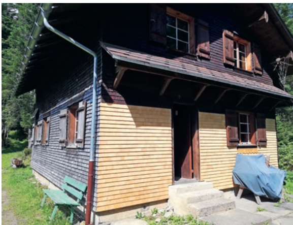
Willi Omlin Hütte mit sanierter Hausfassade
