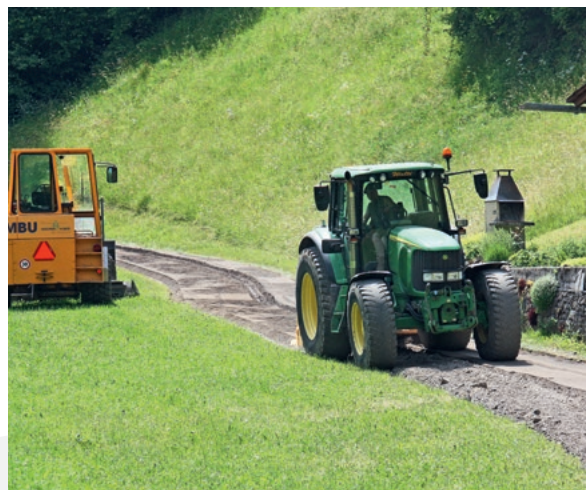
Verfeinern des aufgefärschten Belages mit Mobilbrecher
