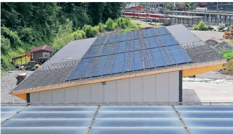
Indachanlage auf dem Heizwerk Gorgen (Vordergrund) mit neu installierter Aufdachanlage auf dem Fahrzeugunterstand der Alligo AG (Hintergrund)
