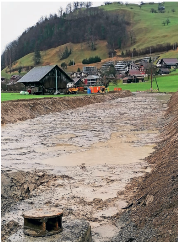
Viel Wasser auf der Baustelle
