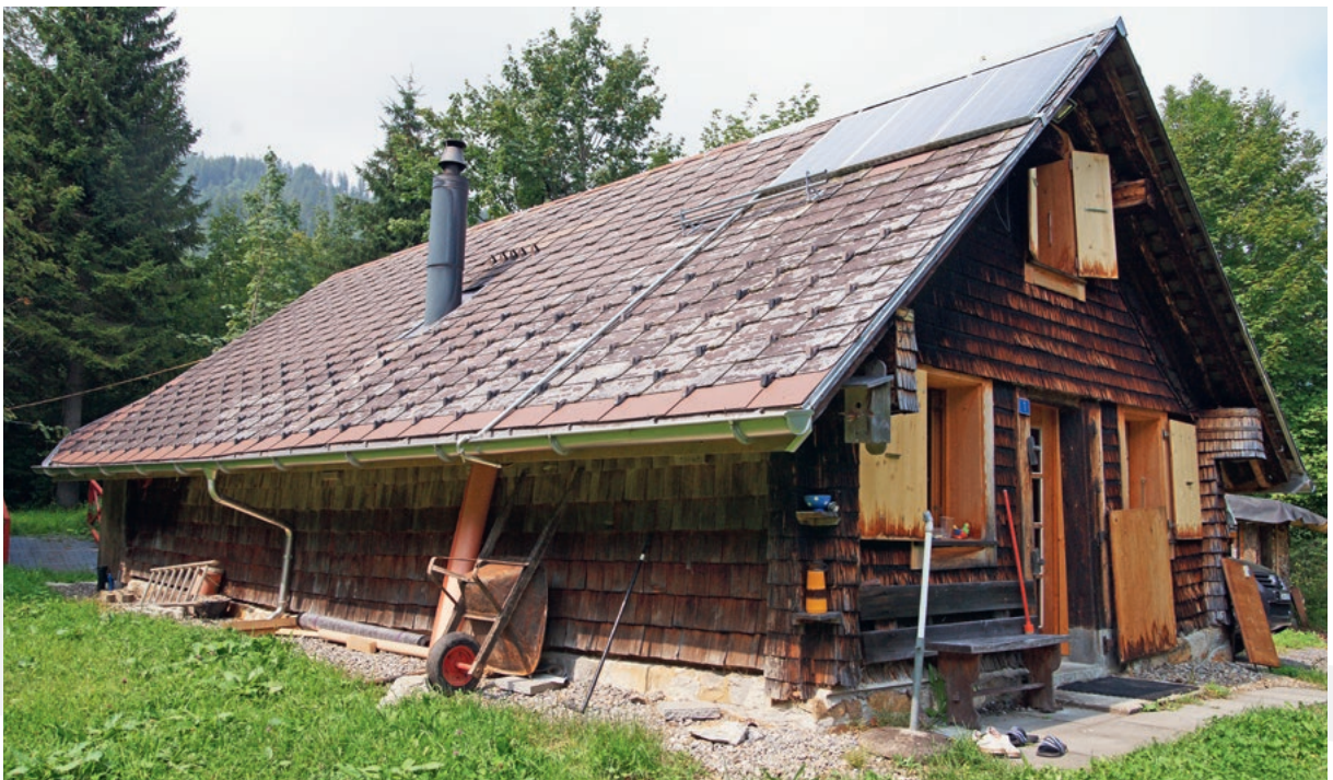
Geplante Dachsanierung Gruonholzhütte
