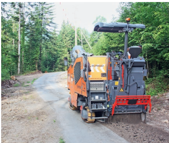
Auffräsen des bestehenden Belags mit Asphaltfräse oberhalb Rotmoosgrabenbrücke
