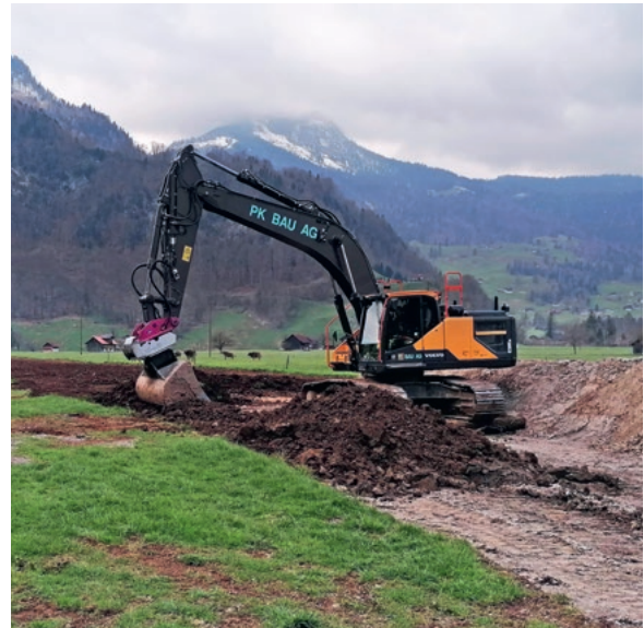
Einbau Unter- und Oberboden in einem Arbeitsschritt
