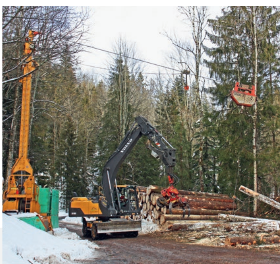
Seilkranarbeiten im Rotmoos/Zwirchistrasse, Produktion von Mondholz
