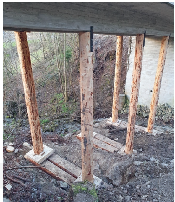
Fertig unterspriesste Brücke
