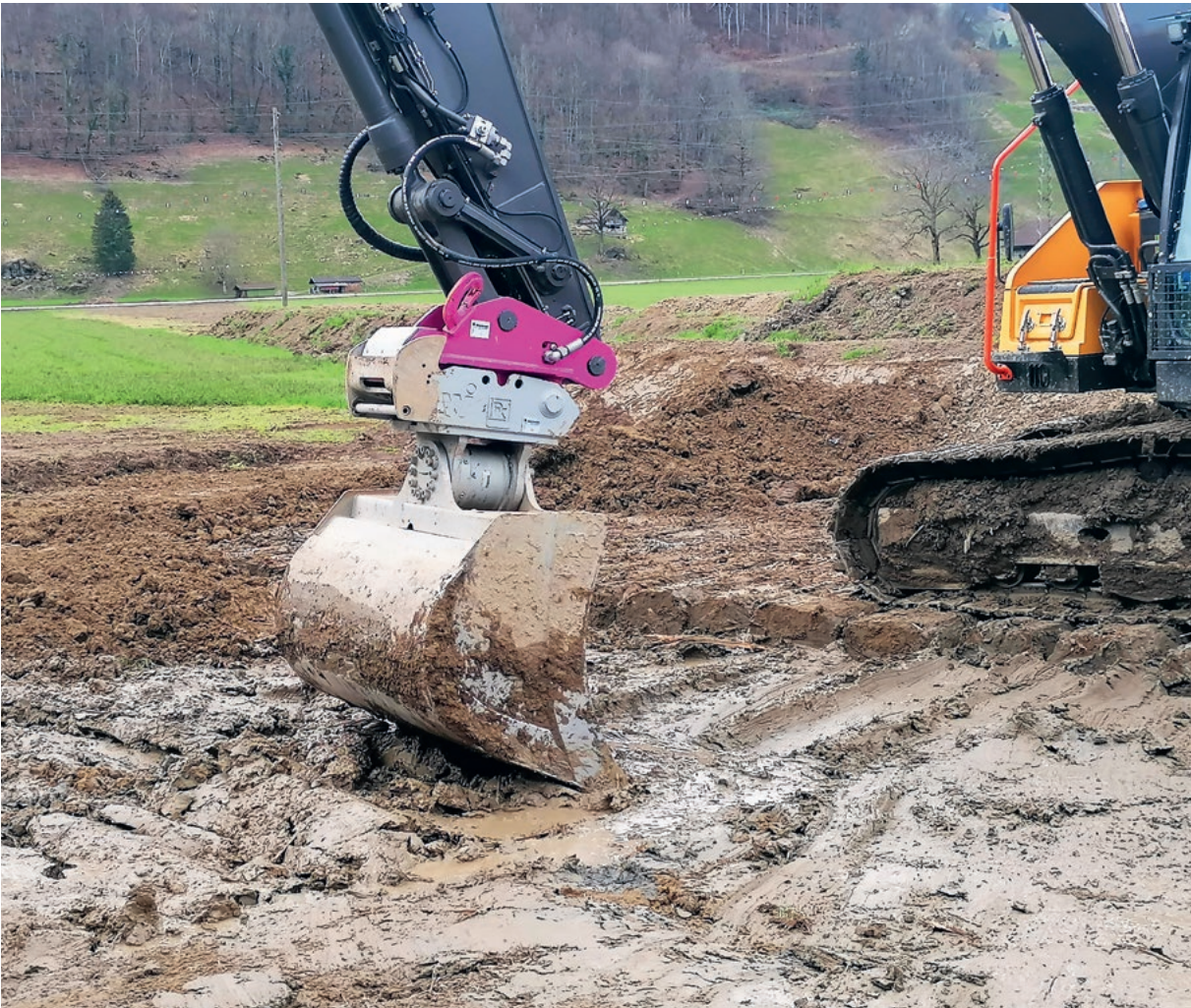
Aufrauen der Rohplanie, im Hintergrund eingebauter Unter- und Oberboden
