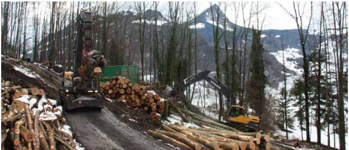
Rodungsarbeiten für Brückencluster zb/Hochwasserschutzprojekt Schmittenbächli im Aeschiwald
