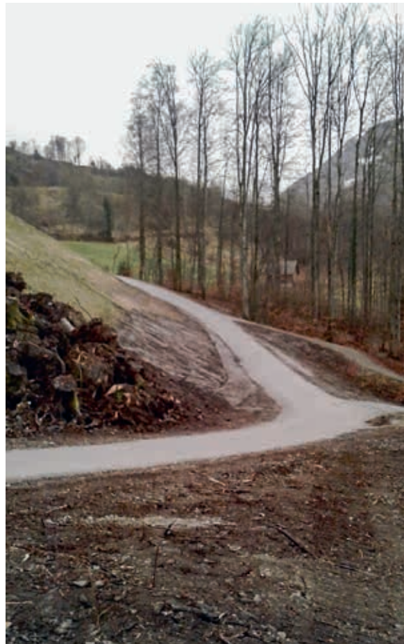
Fertig erstellte Erschliessung «Stocki»
