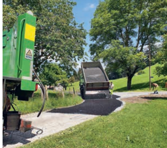
Einbau der dreifachen Schottertränkung durch Euphalt AG im Emmetti
