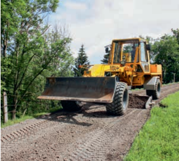
Einbau des aufgebrochenen Belages als Feinplanie durch W. Kiser
