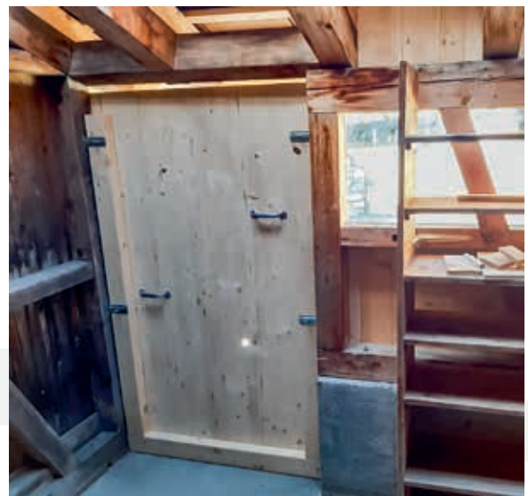
Wintertüre beim oberen Eingang
