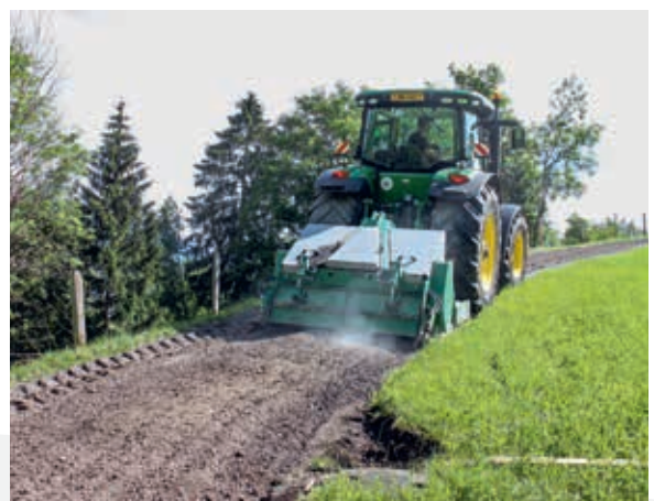
Abbrechen der bestehenden Belagsschicht durch W. Kiser
