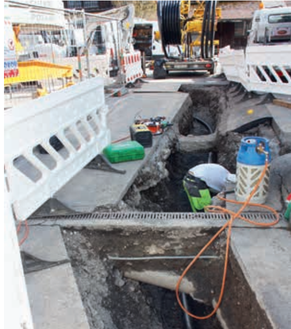
Fernwärme-Leitungsbau im Birkenweg/Garage Koch in engen Verhältnissen
