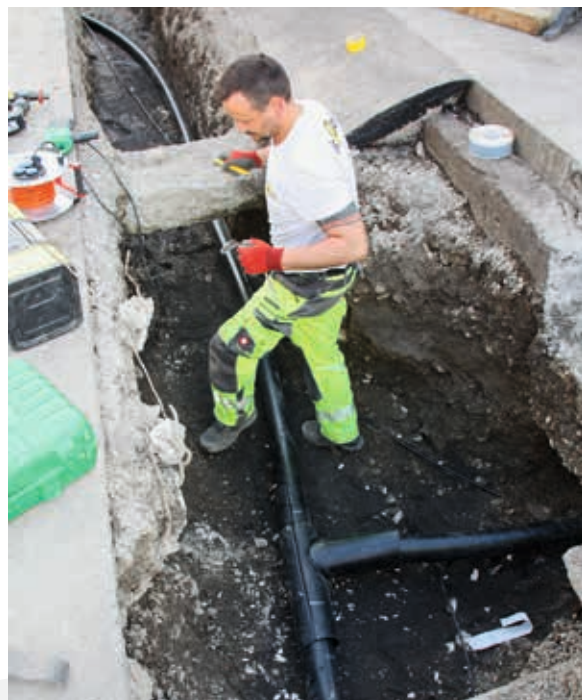
Abzweigung ab FWL für Hausanschluss Garage Koch bei der Fertigstellung
