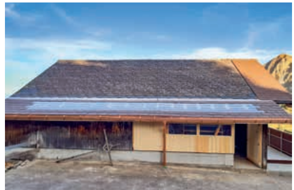
Ersatz Lichtplatten und Sanierung Dach
