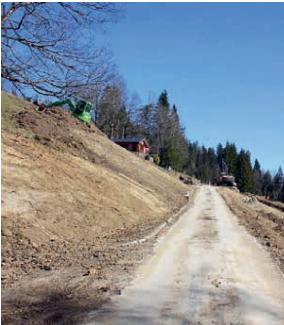
Gestaltung der berg- und talseitigen Böschungen im Bereich Schwand/Bachflysch
