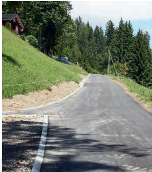
Fertig sanierte Strasse im Bereich Schwand/Bachflysch
