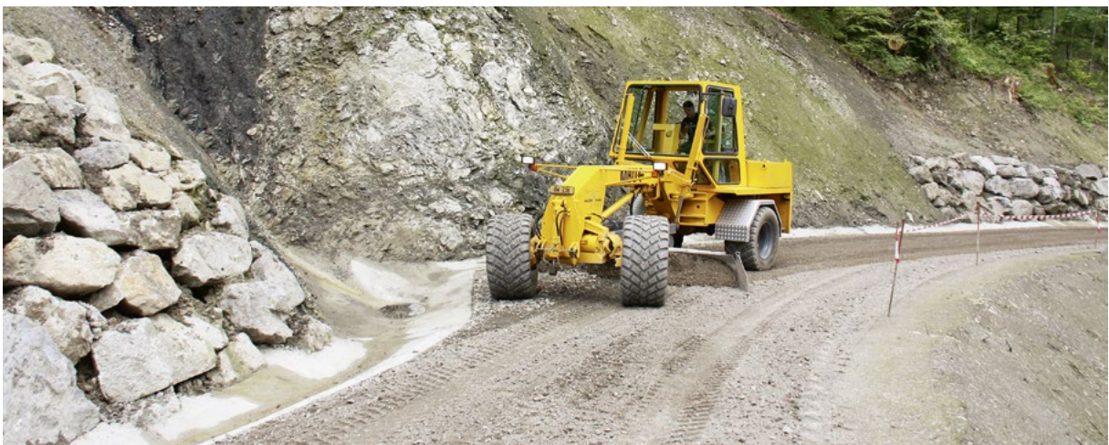
Erstellen der Feinplanie mit bergseitigem Quergefälle
