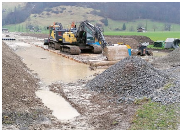
Bagger stehen auf den Baggermatratzen
