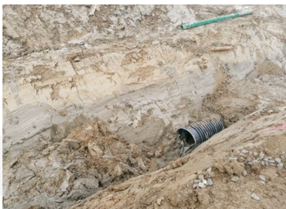
Eingebaute Drainage, der schlechte Boden ist hier gut erkennbar
