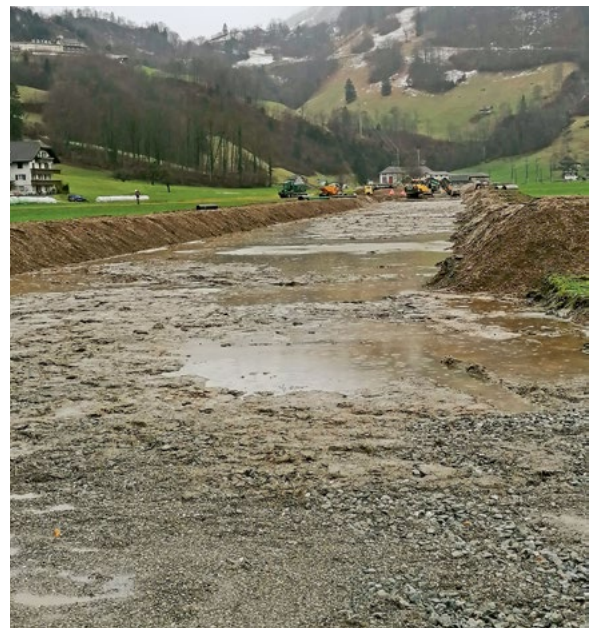
Fertig erstellter Teil der Drainageleitung
