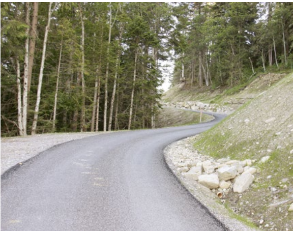
Der fertig sanierte Strassenabschnitt Zwirchiwald
