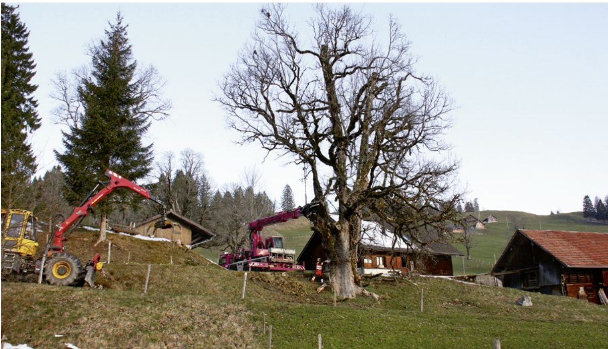
Abstützen des grossen Bergahorn im Iwi mit Spezialgerät der Fällag AG
