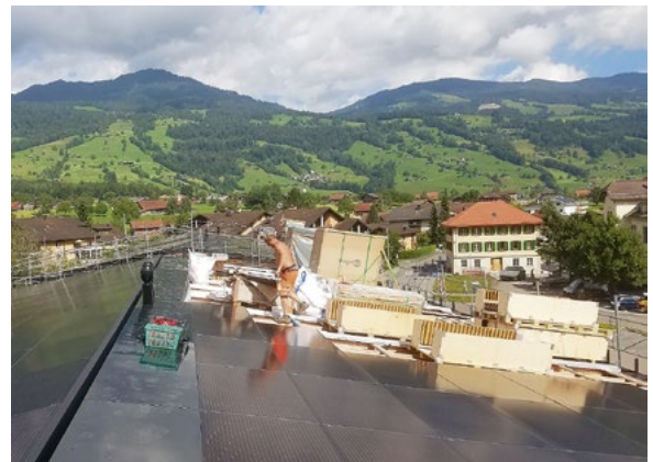
Fertigstellungsarbeiten PVA Haus B
