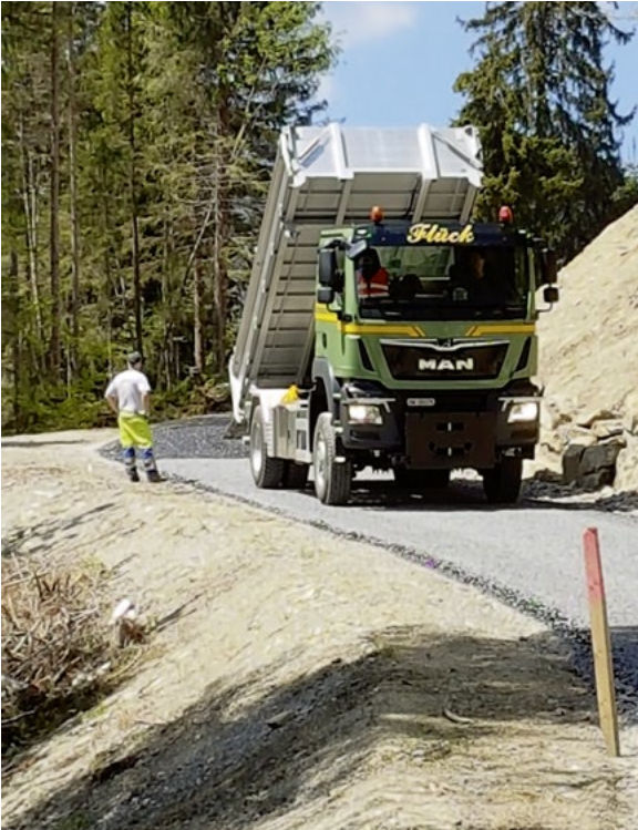
Einbau der dreifachen Schottertränkung am 28. Mai 2020
