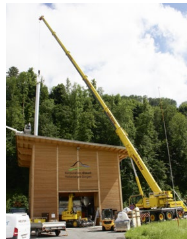
Montage des neuen Kamins
