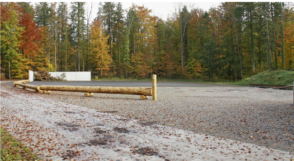
Fertig erstellter Schwemmholzplatz Pfedli
