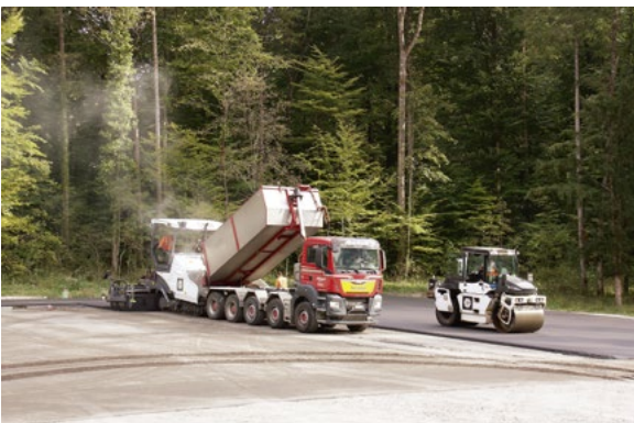
Einbau des HMT Belages im Pfedli
