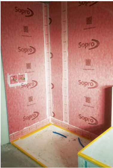
Duschebereich mit Abdichtung
