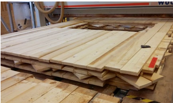
Ein Wandelement entsteht
