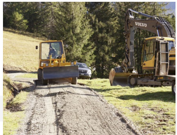
Einbau von Planiematerial mit Grader an der Zwirchistrasse/Zwirchialp
