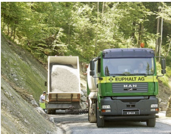
Einbau der dreifachen Schottertränkung am 23. Juni 2020
