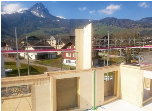
Montage Aussenwände
