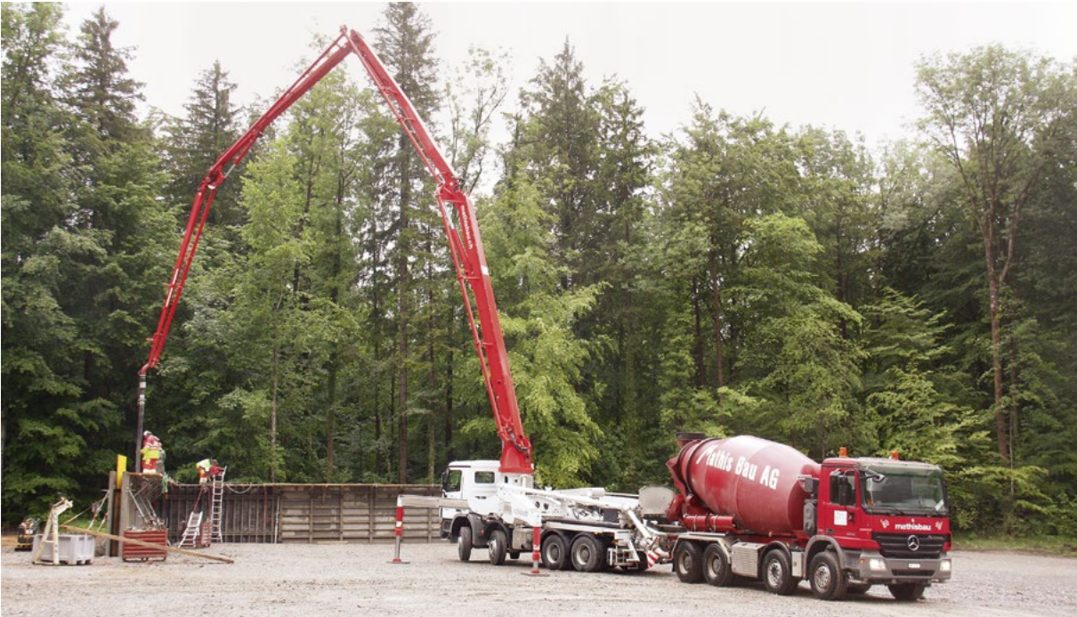
Betonieren der Begrenzungsmauer im Pfedli
