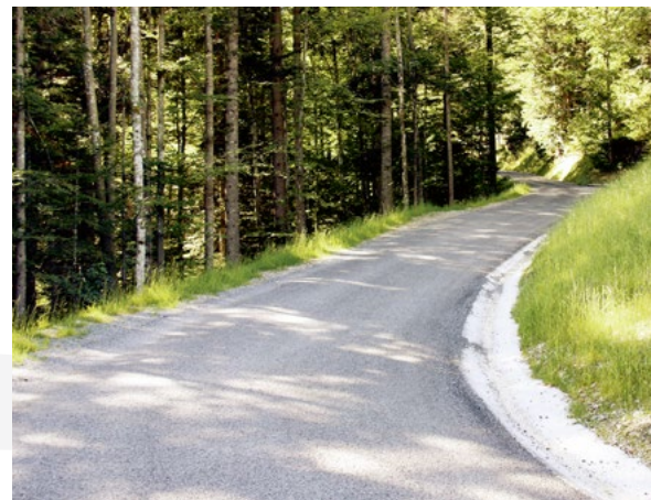
Fertig sanierter Strassenabschnitt Bereich Meisibüelegg
