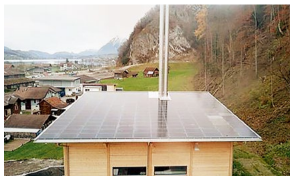
Indachanlage auf dem Heizwerk Gorgen
