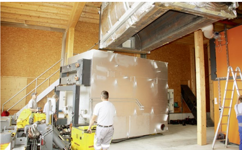
Installation des Heizkessels. Der obere Teil (ca. 10 to) wird mit einem Spezialkran an die Decke des Zwischenbodens gehoben, der untere Teil des Heizkessels (ca. 20 to) mit hydraulischen Panzerrollen darunter platziert.
