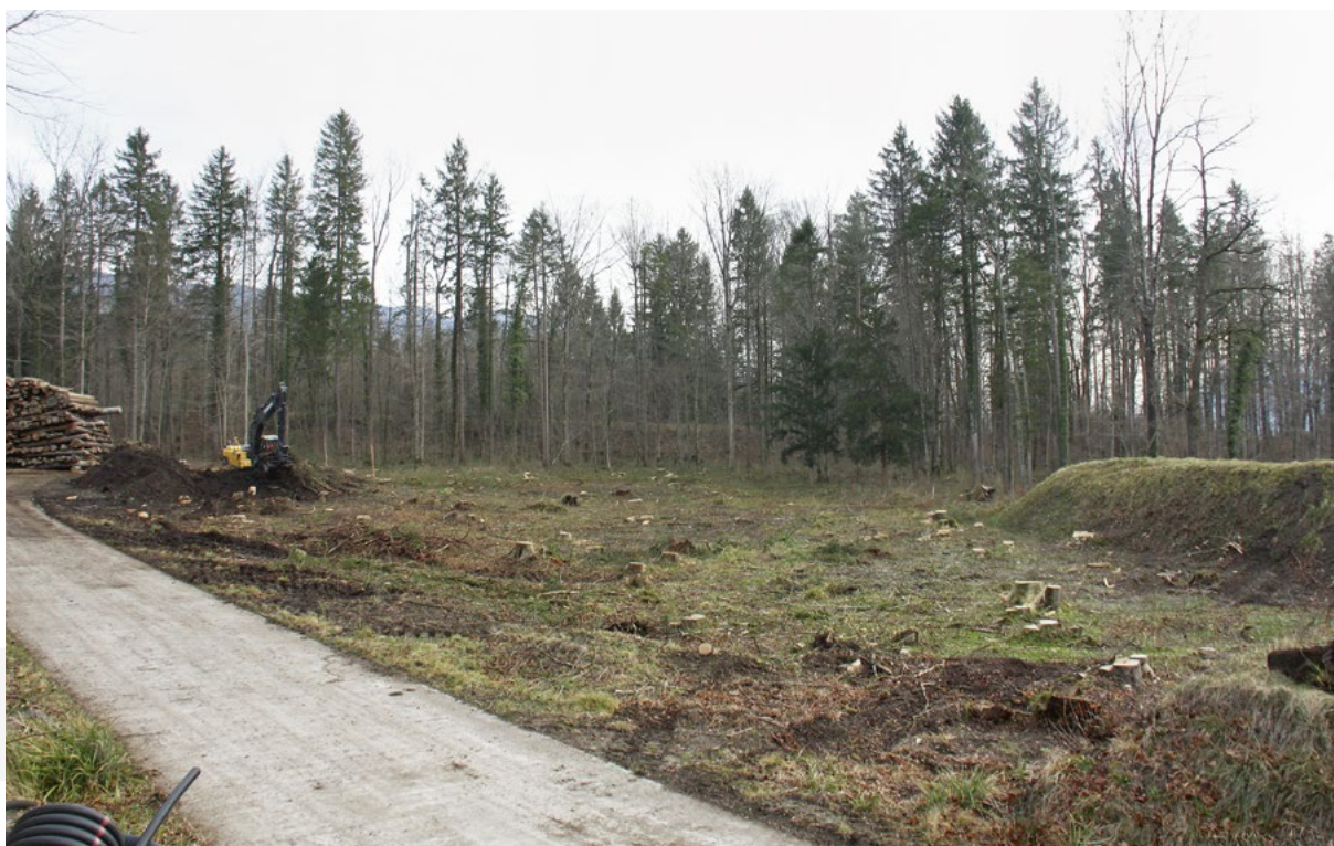
Vom Baumbestand befreite Fläche für den Schwemholzplatz Pfedli
