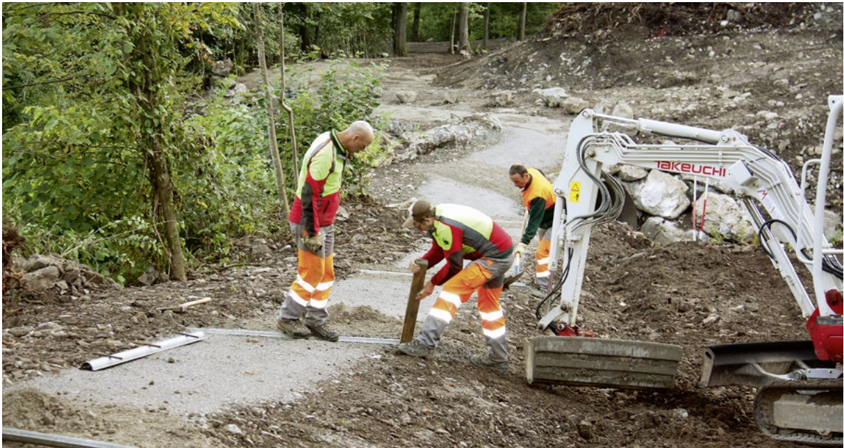
Fertigstellungsarbeiten am Wanderweg Buochholz durch Huby, Marco und Peter
