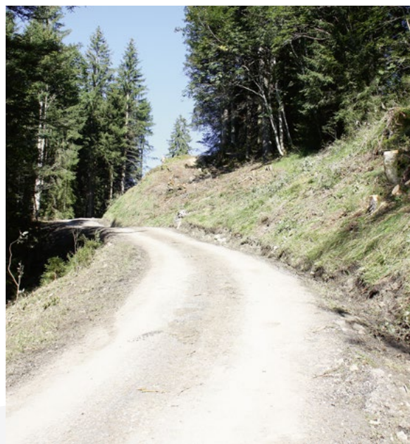
Strassenverlauf vor der Sanierung, der Projektperimeter ist bereits ausgeholzt
