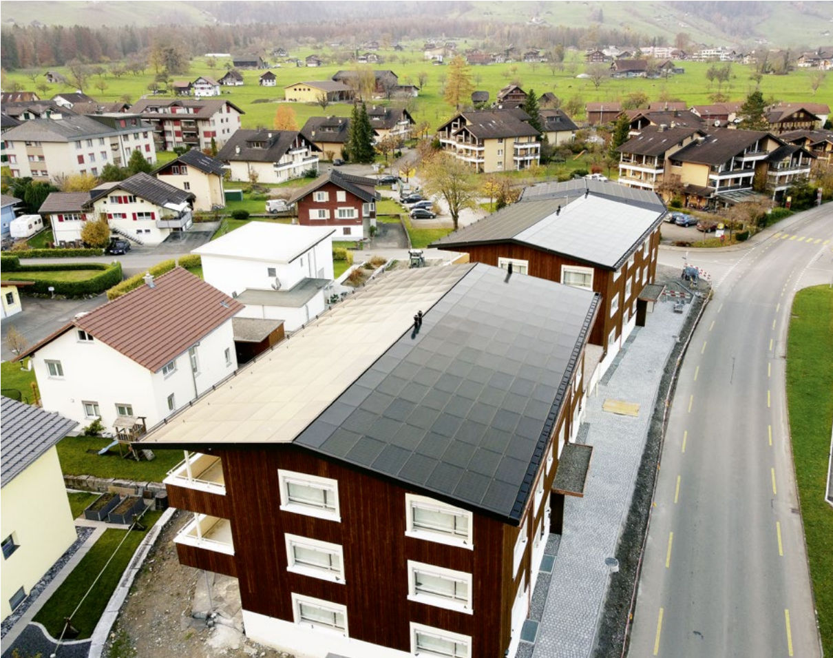
Indachanlage PVA ZEV Sunnäplätzli
