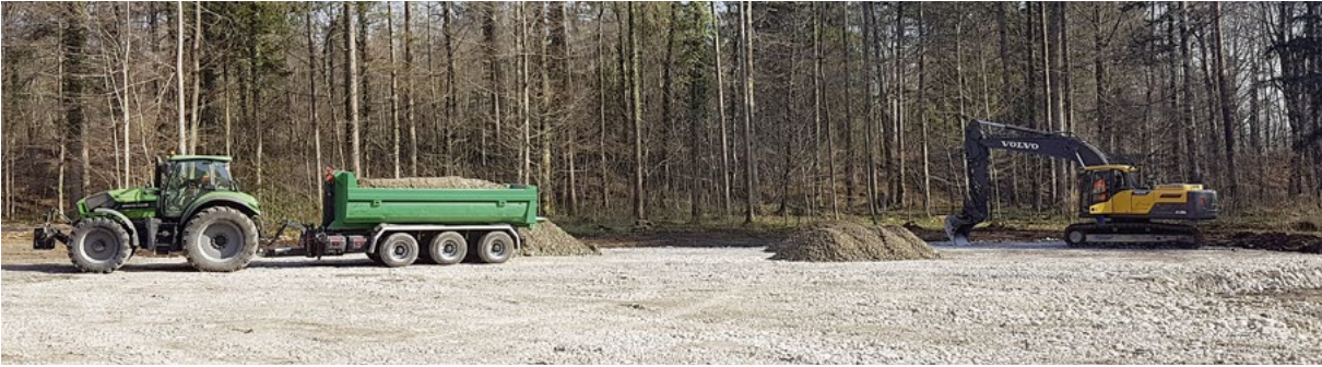
Zufuhr und Einbau von Kiesmaterial 0–50 mm als Abschluss der Schüttung im Pfedli
