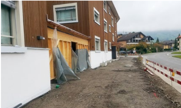
Zugang Haus A und B
