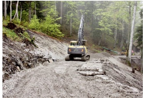
Einbau der Kiesschicht (Tragschichtverstärkung), die bergseitige Sickerleitung ist bereits eingebaut
