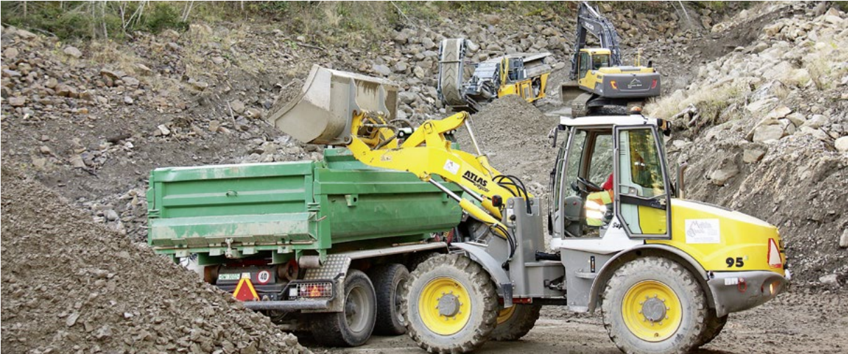
Kiesaufbereitung in der Mettenlaur mit Brechanlage, Verlad und Abfuhr des Materials
