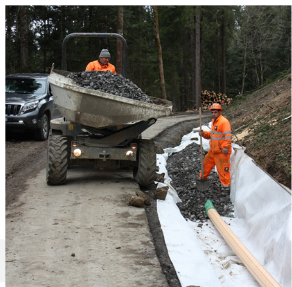
Einbau der Sickerleitung unterhalb Wendepalte Schwalbennest durch Mitarbeiter der Implanzia Schweiz AG
