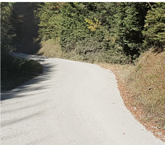
Selistrasse oberhalb Selirank: In Top-Zustand nach der Instandstellung
